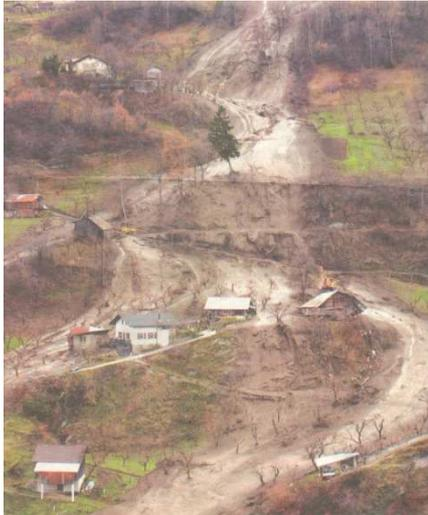
Figure 7. Glissement de terrain généré par la rupture de la galerie en charge de Cleuson-Dixence
