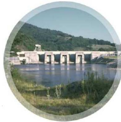
Figure 3. Centrale d'éclusée : Argentat (48 MW)
