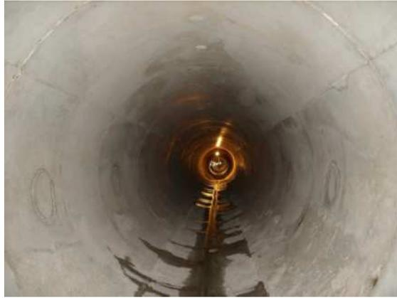
**Figure 10. Revêtement en béton coffré**
