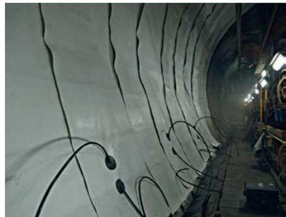
Figure 54. Mise en place du système d'étanchéité et installation des tubes d'injection
