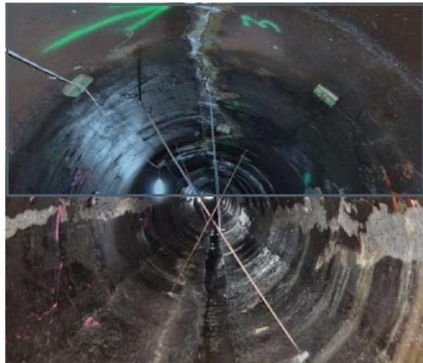
Figure 6. Rupture du revêtement de la galerie de Pucara, ayant généré un glissement de terrain (Panama)
