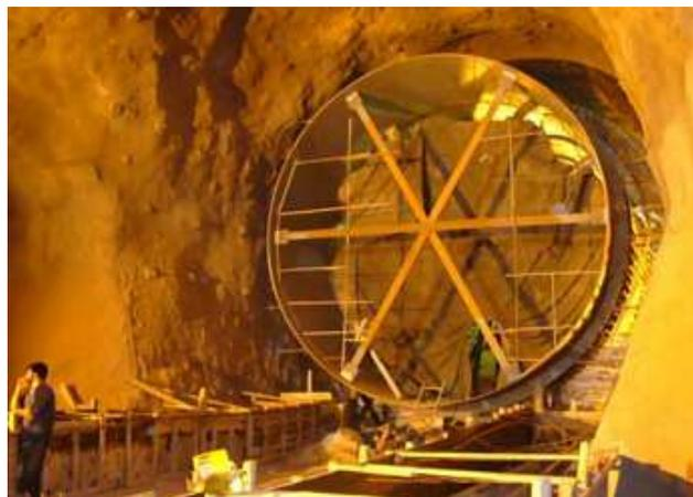
Figure 12. Installation d'un blindage métallique (Réf. [27])
