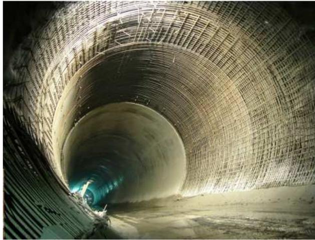
Figure 11. Ferrailage et bétonnage d'une galerie (Réf. [27])
