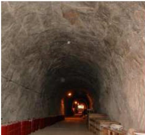
Figure 9. Galerie hydraulique non revêtue, massif et compact
